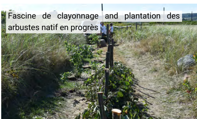
La fascine de clayonnage a créé un enclos pour le passage de piétons, un mois après construction.
